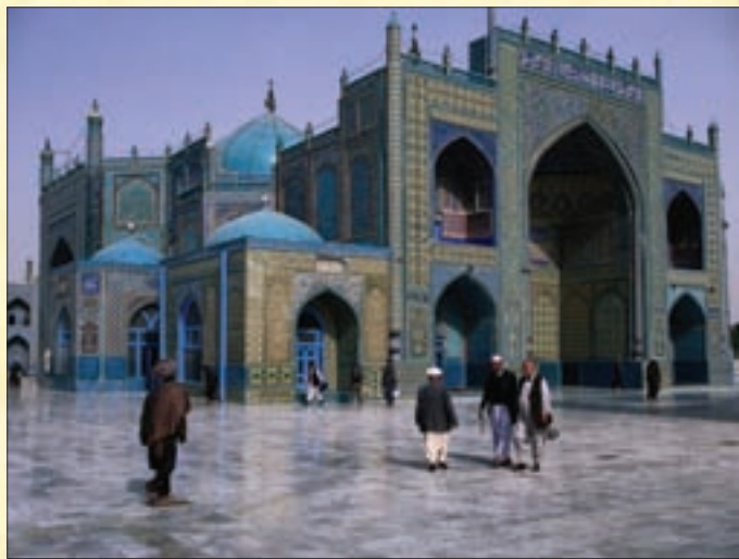
بنای مسجد آبی در مزار شریف
